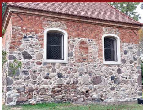
Die hier fast fertige Ostfassade erstrahlt in neuem Glanz.
