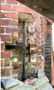
Links: Rostige Mauerbewehrung Unten: Begutachtung der Fenster
