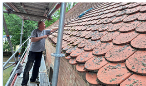
Matthias Kaulbarsch nutzt das Gerüst, um unser Kirchendach vom Moosbewuchs zu befreien
