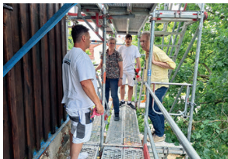
Baubesprechung in luftiger Höhe
